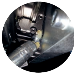
Leckage am Schmiernippel (Gewinde sind zu kurz)
